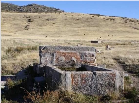
Fuente Los Trampales. Se encuentra a la entrada del pueblo, viniendo desde Navadijos. Se trata de un abrevadero de granito, con dos caños y un pilón corto y rectangular.
