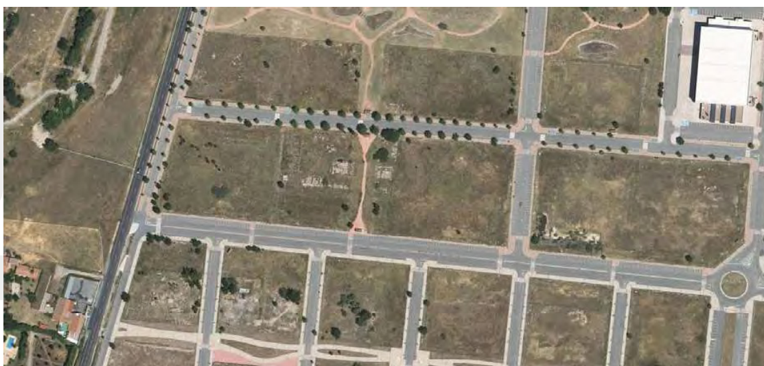
ORTOFOTO DEL AMBITO DE LA PARCELA EN SECTOR "SOTO II". TERRENOS SIN EDIFICAR
