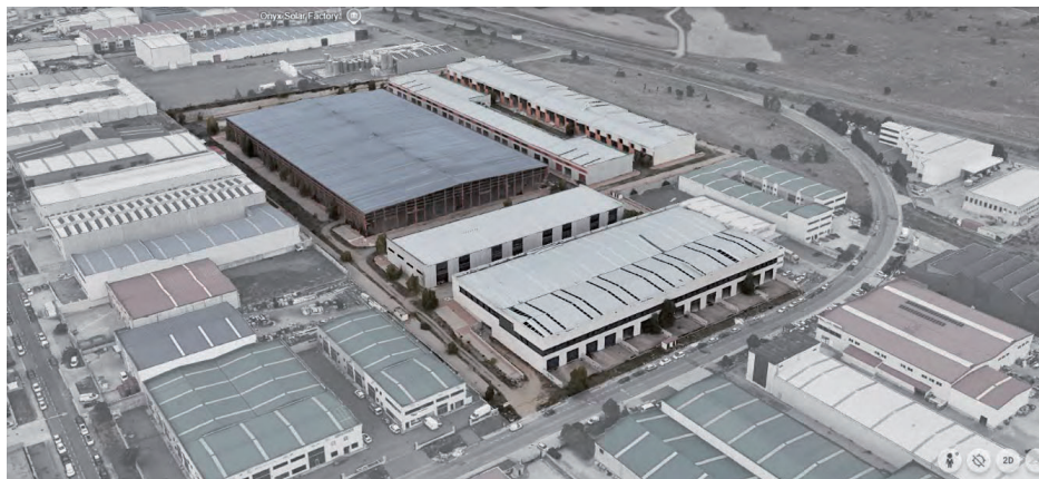
Vista zona sureste S-E.
