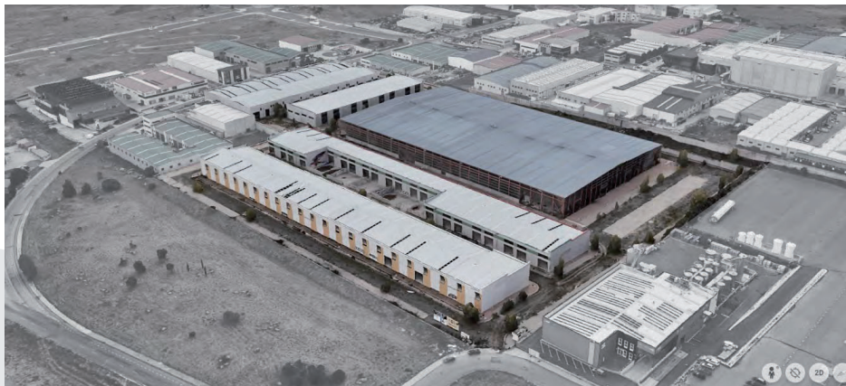
Vista zona noroeste N-O.
