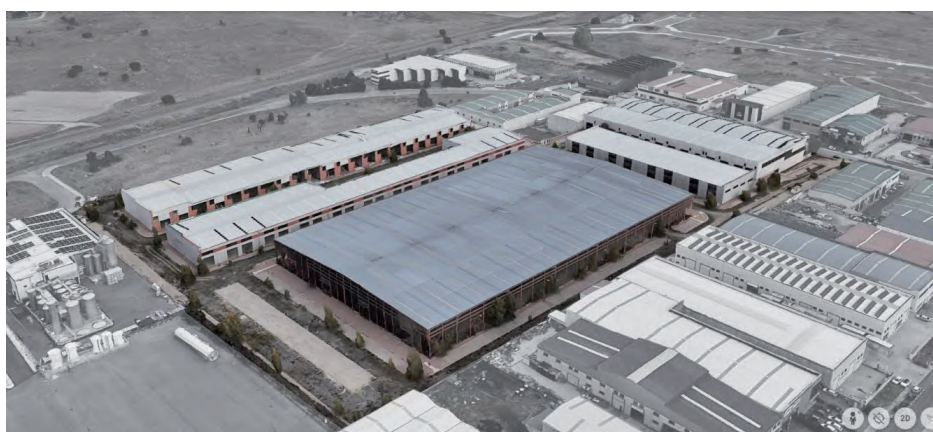
Vista zona suroeste S-O.
