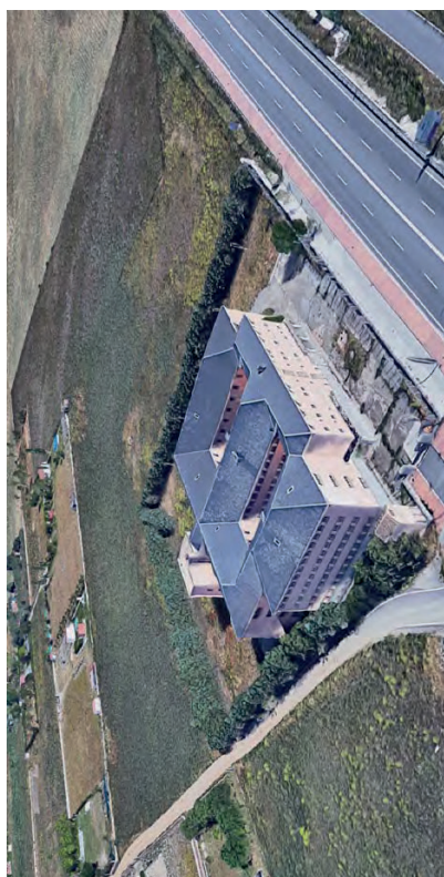
Fotografía 6. Levantamiento 3D de las construcciones existentes y parcelas de alrededor
