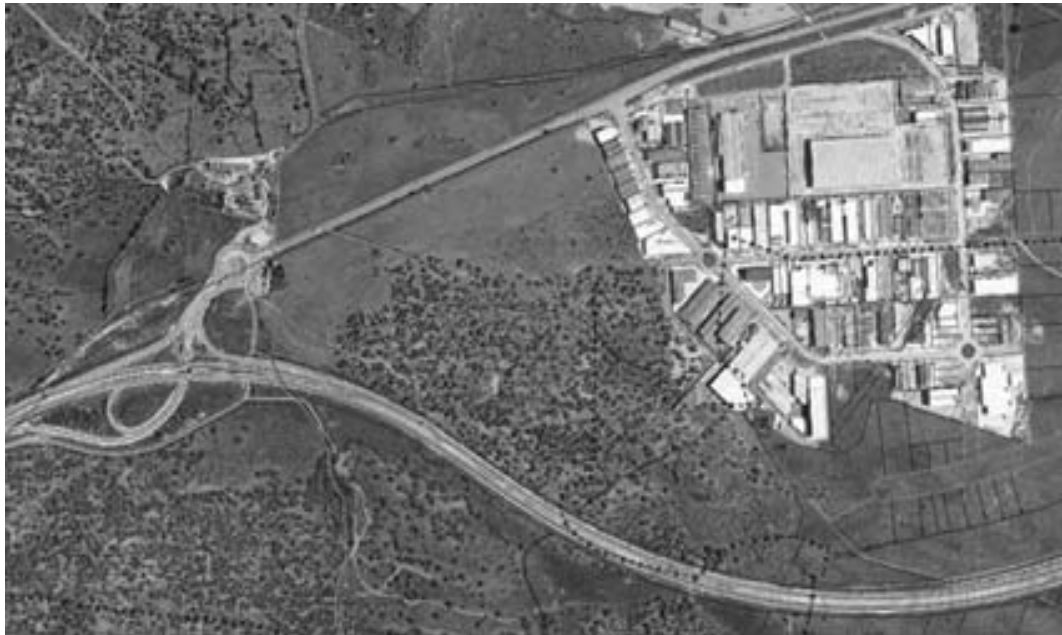
Vista general del sector SUR PP 20-A POLÍGONO INDUSTRIAL DE VICOLOZANO
