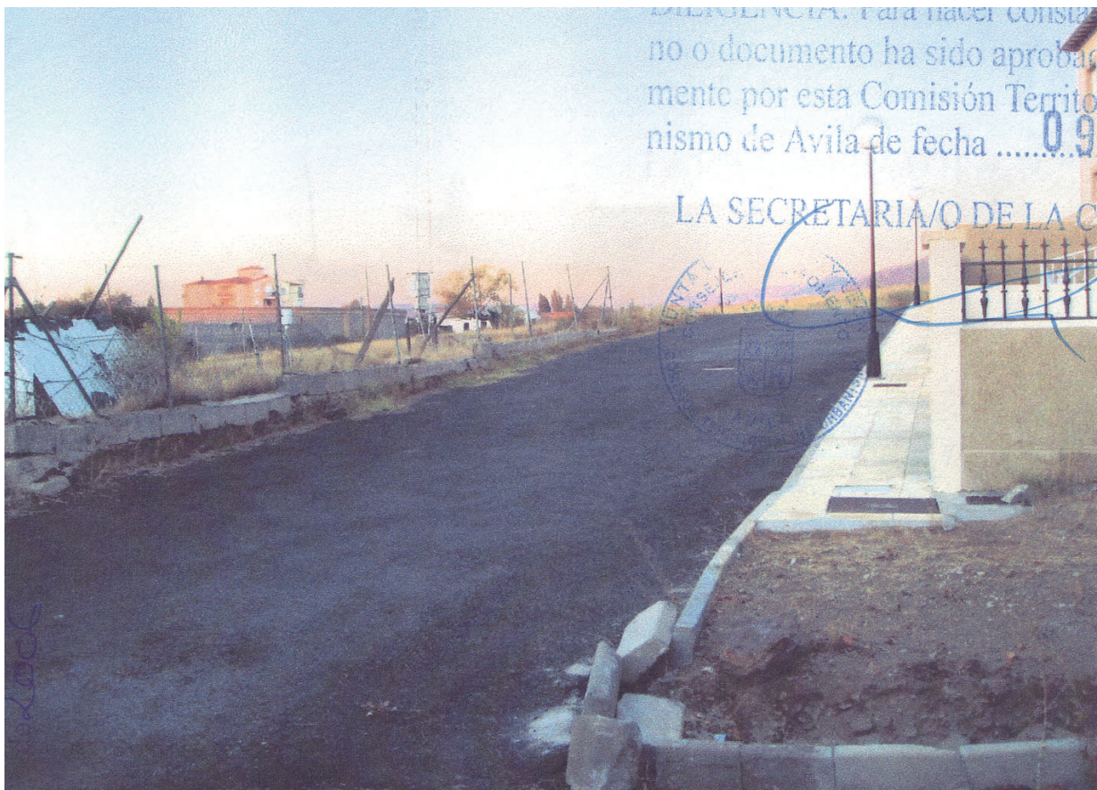
Calle abierta a la UE-2, entre las tres viviendas y parcela excluida
