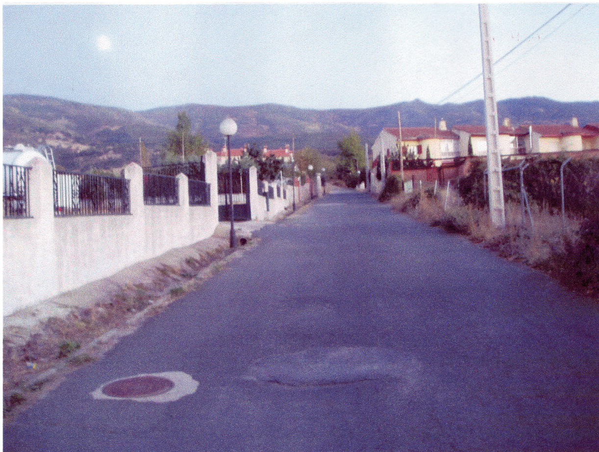
Vista general de la calle desde la zona norte de la calle
