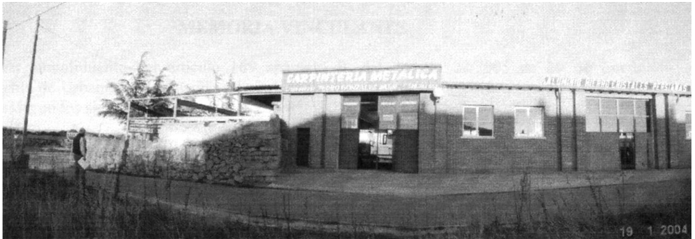
Zona industrial en el lateral de la manzana.
